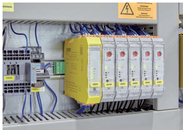
Obr. 4 Hybridné motorové spúšťače CONTACTRON majú integrované všetky dôležité funkcie v celkovej šírke len 22,5 mm.
